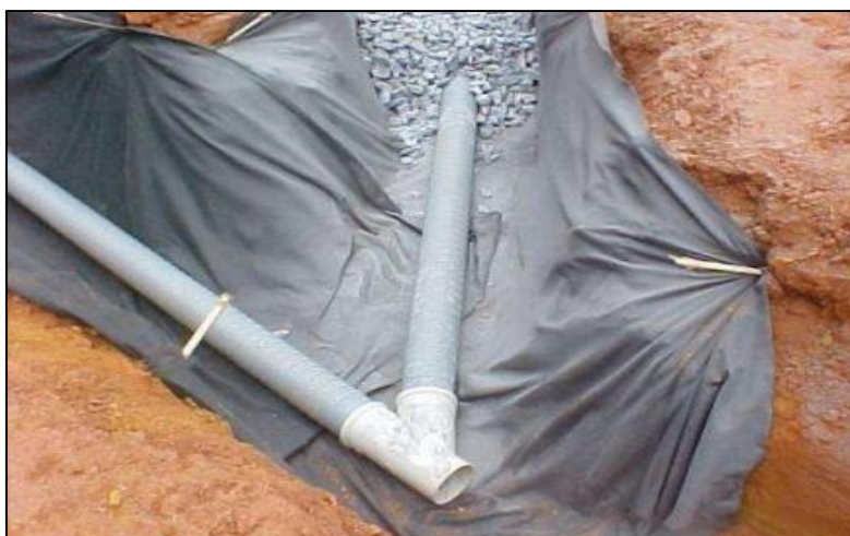
Figura 05 – Modelo da instalação da drenagem de percolado
