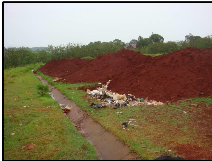
Figura 03 – Canaleta de drenagem principal
